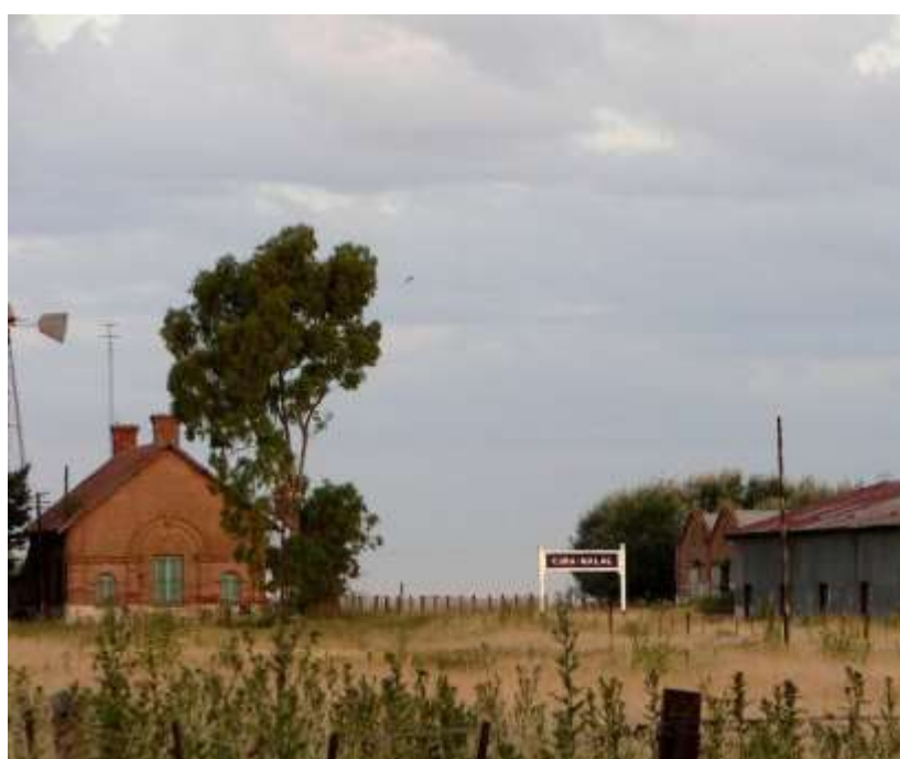
Fig 2. Estación de ferrocarril de Cura Malal. Fuente: creación propia.
